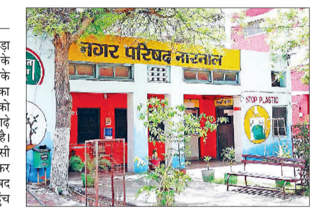
नारनौल। नगर परिषद भवन। फोटो: हरिभूमि
